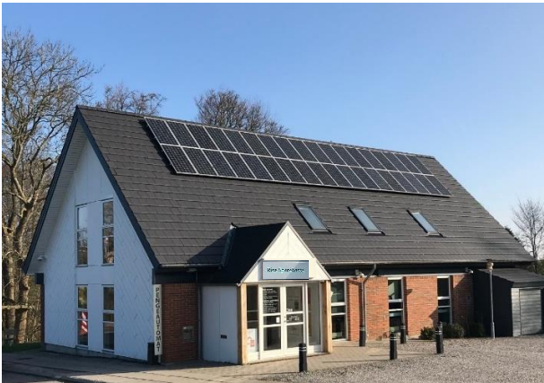
Solcelleanlæg på filialen i Flemløse
